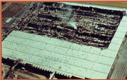
Brand is binnen de brandwerende compartimentgrens gebleven door gebruik te maken van de juist geplaatste brandwerende voorzieningen. De schade bleef hierdoor beperkt en was de continuïteit gewaarborgd
