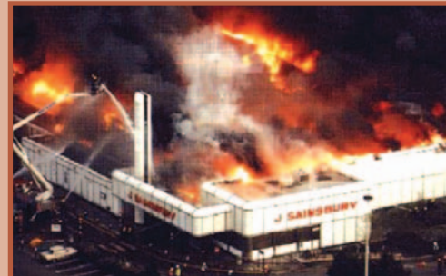
Brand is binnen de brandwerende compartimentgrens gebleven door gebruik te maken van de juist geplaatste brandwerende voorzieningen. De schade bleef hierdoor beperkt en was de continuïteit gewaarborgd
